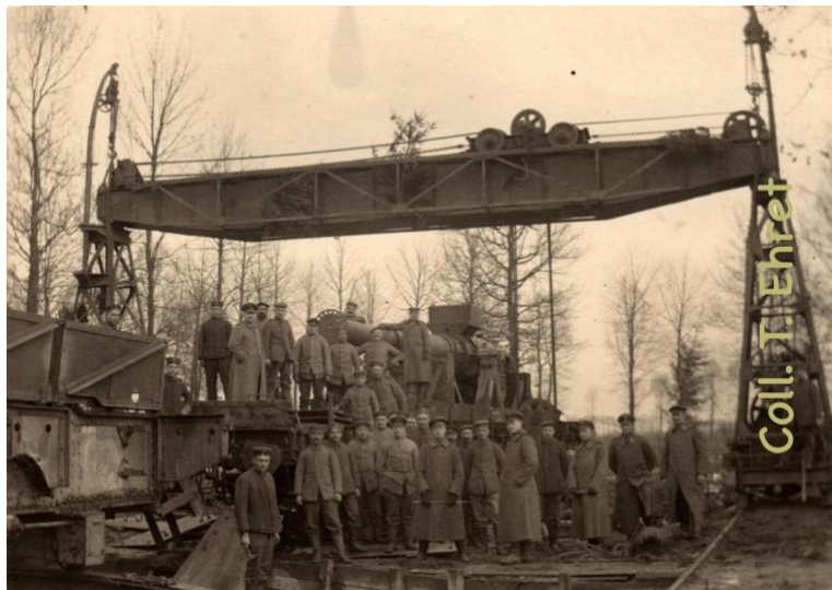
Installation d'un canon de 24 cm Theodor-Karl, à l'aide d'un portique de levage, dans un lieu non identifié.
