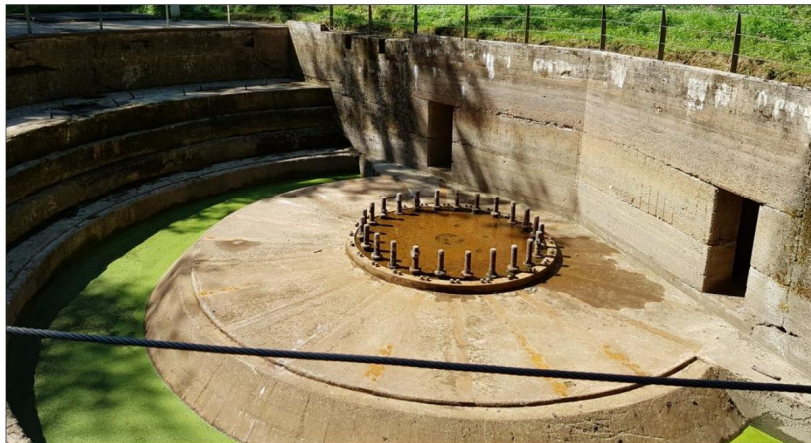
Des grands canons comme celui de Zillisheim ont été construits par les Allemands pendant la Grande Guerre dans une dizaine de communes, depuis la mer du Nord, près d'Ostende, jusqu'à l'Alsace. Photos L'Alsace
